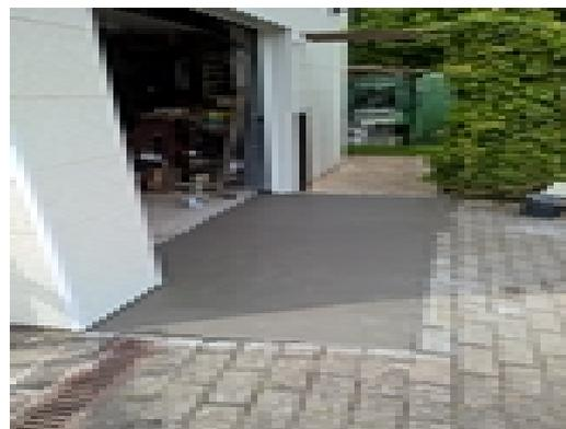
Die Austrocknung erfolgt in wenigen Stunden. Danach werden mit dem GREESIVE BS Betonlack als Finish noch die letzten Unebenheiten beseitigt und die Fläche zusätzlich versiegelt. Die Einfahrt kann danach unmittelbar wieder befahren werden.
